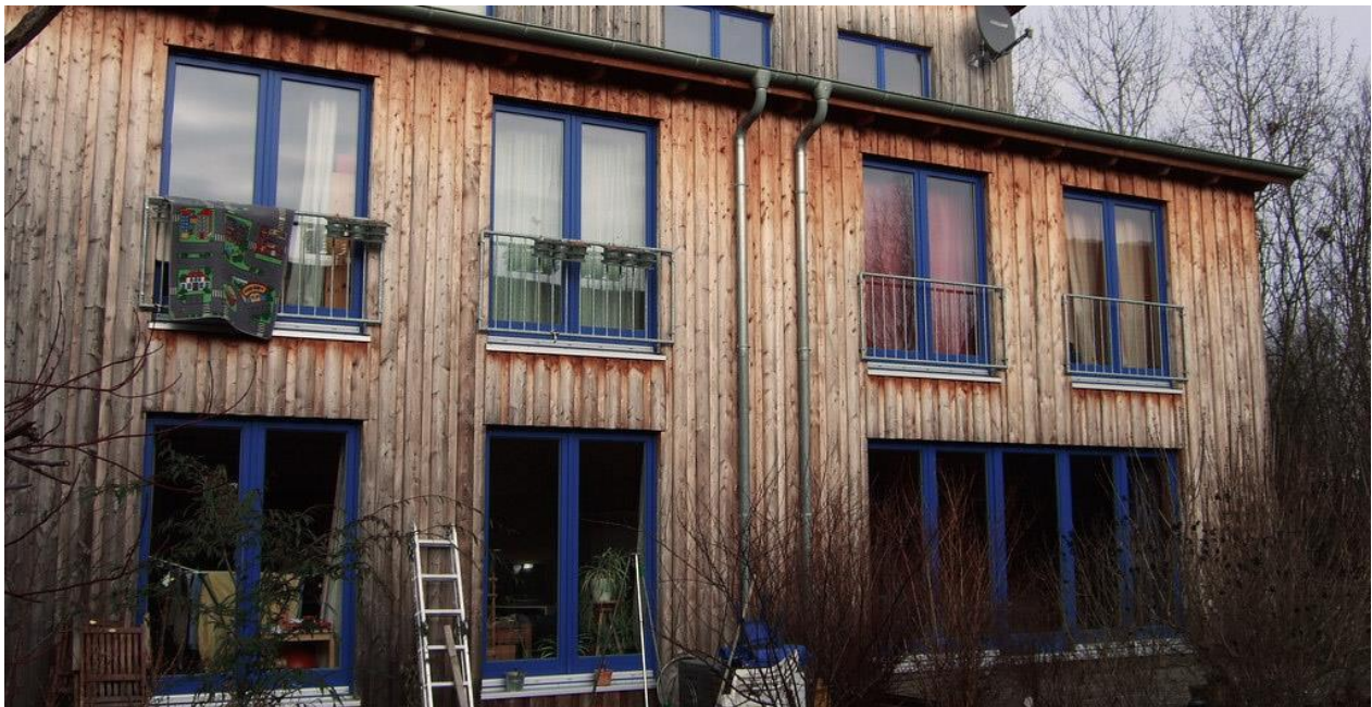
Une maison écologique, indépendante du réseau d'assainissement communal et au traitement et à la réutilisation autonome des eaux usées. © A. Schöpe (Jan. 2009)
